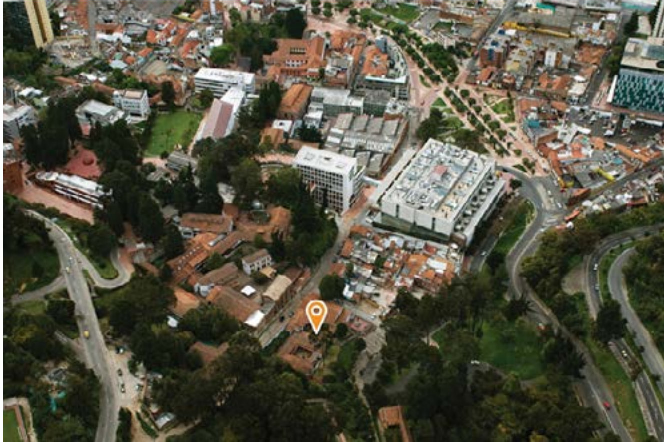
Figura 6. Vista aérea de la Universidad hacia el suroccidente. Fuente: Gerencia del Campus, Universidad de los Andes.
