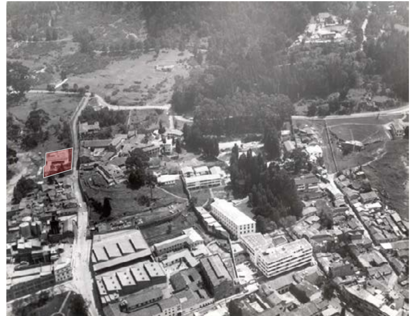
Figura 2. Foto histórica del sector donde se aprecia los Bloques Z, Rgc, G, B, la Fábrica Germania, la zona del Campito y los predios donde se instala la Sociedad Bolivariana (1968). Fuente: Archivo Saúl Orduz, Archivo de Bogotá.
